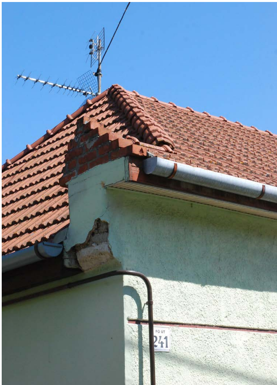
[60] MAGASÍTOTT OROMFAL ÉS ERESZCSATLAKOZÁSA
