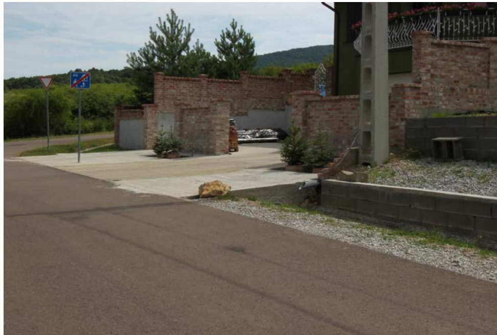
[116] TÚLZOTT MENNYISÉGŰ BURKOLAT fotó: Tunnel Kft.
